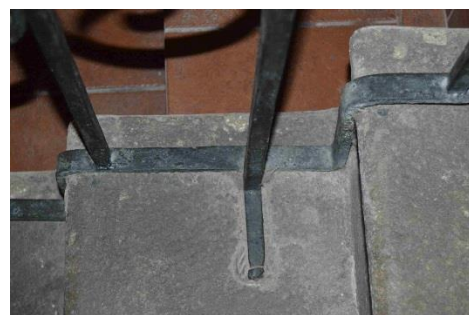
detail kotvení zábradlí do stupňů schodiště
