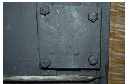
detail krabicového zámku
