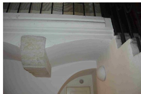
pohled na nosnou konstrukci pavlače s krakorcem
