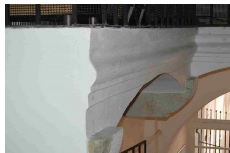
detail profilu zakončující římsy
