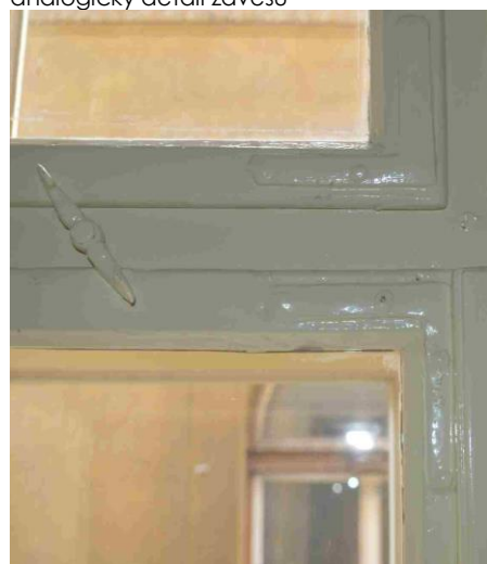
analogický detail zavírání s obrtlíkem
