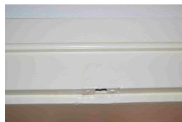
detail horní části zárubně se západkou pro zástrč
